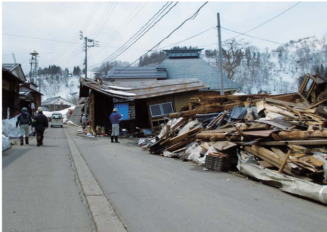
写真1 長野県北部地震の被害（栄村青倉）
